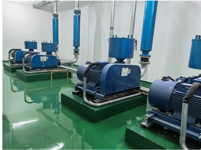
风机下设浮筑基础
